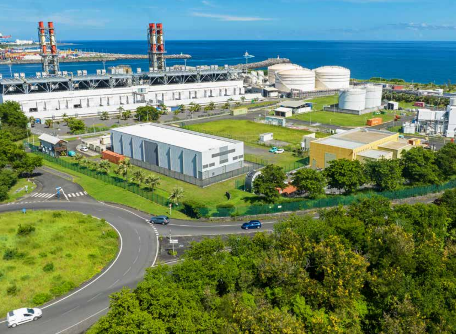
La centrale thermique Bioénergie du Port est la plus puissante au monde (Crédits photos : Serge Marizy - Capa Pictures)
